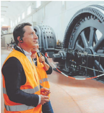
Besichtigung der Power-to-Gas-Anlage am Wasserkraftwerk Whylen, die mittels Elektrolyse aus Wasser Wasserstoff herstellt (mit Jonas Hoffmann Mdl).
